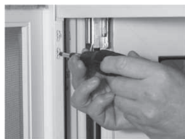
④はずしたときは逆に、取付ねじを締める
