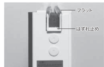
障子はずれ止めのセット前
